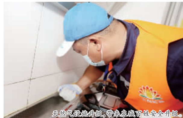
天然气设施升级,带来泉城百姓安全升级。
